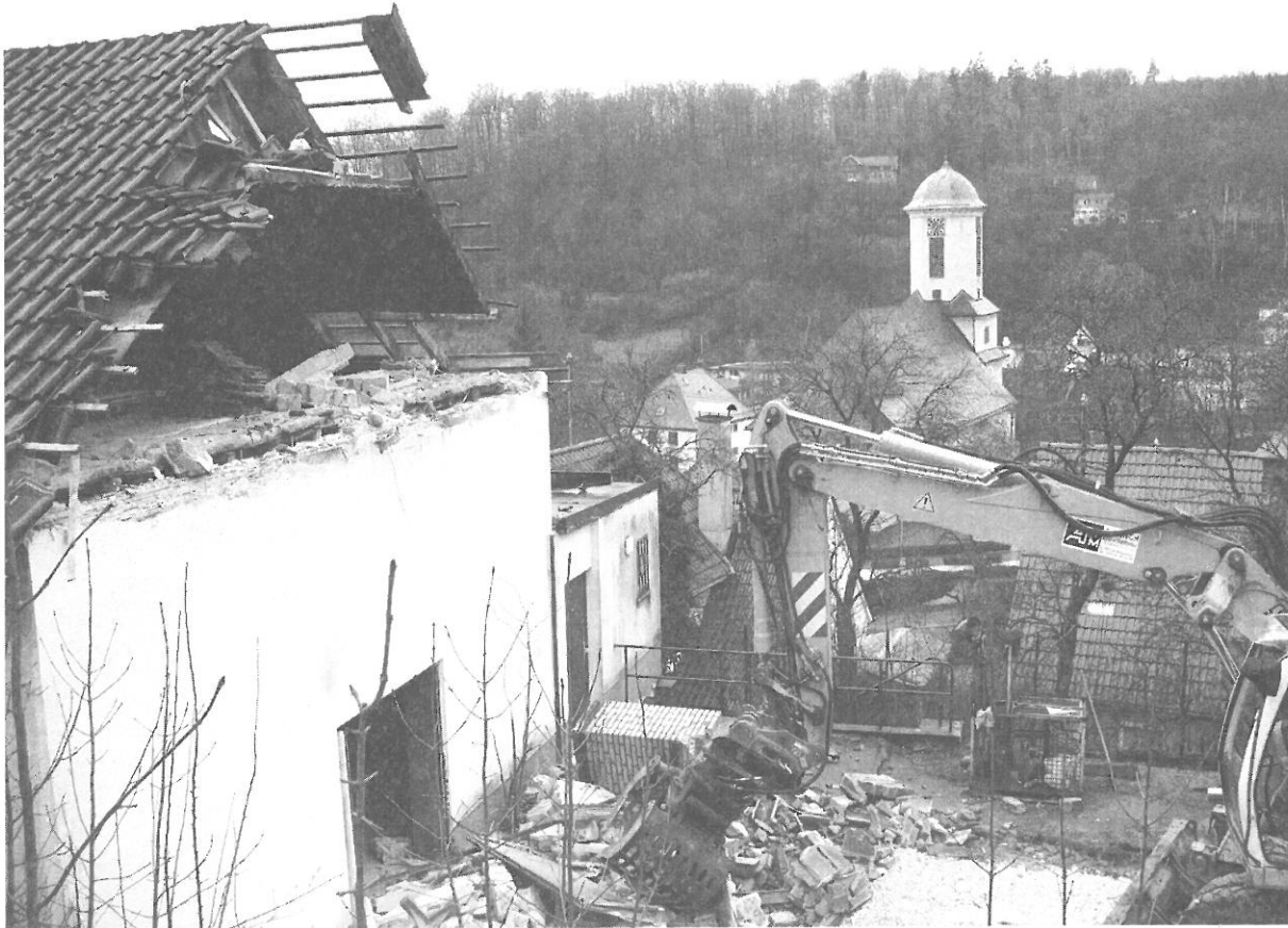
Abbruch der Bergturnhalle am 13. Dezember 2007 (Foto: Gemeinde Blaustein)
