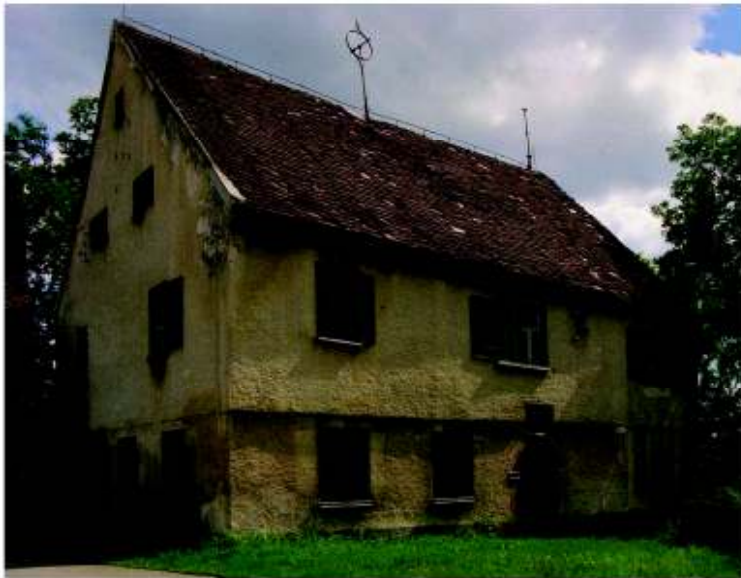
Hohenstein von Nordwesten vor dem Abbruch
